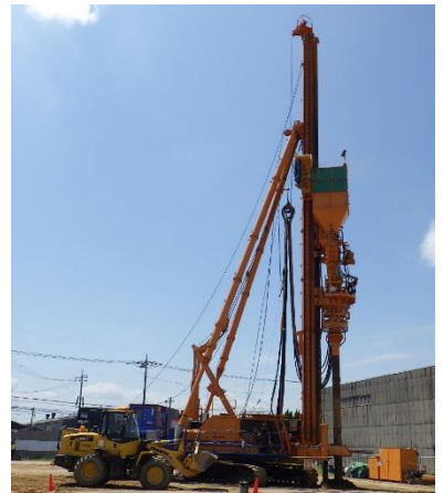
SAVE コンポーザー施工状況
