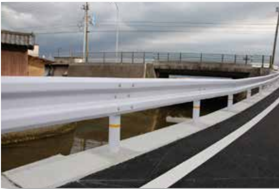
■風早地区吉末川護岸整備工事 ■ 広島県 東広島市役所
