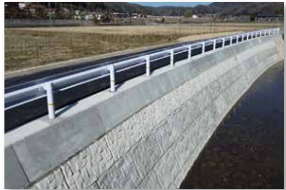
■仏通寺川河川災害復旧工事(第1345号) ■ 広島県 東部建設事務所 三原支所
