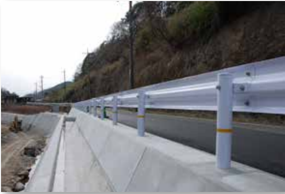
■二級河川瀬野川水系瀬野川河川災害復旧工事 (平成30年災害第4265号 2工区) ■ 広島県 西部建設事務所
