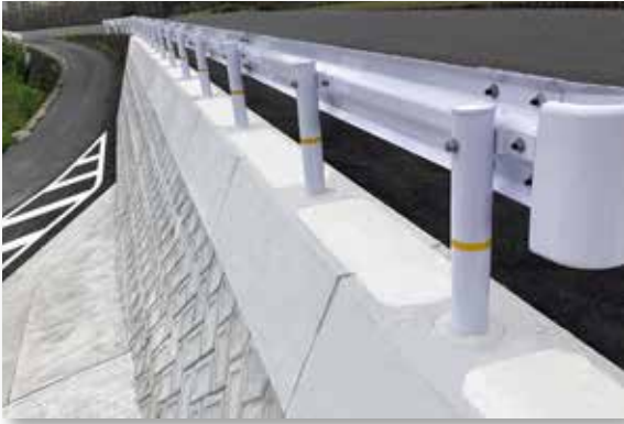
■佐伯5区8号線ほか1路線道路改良工事(3-1) ■ 広島県 広島市佐伯区役所(間知ブロック)
