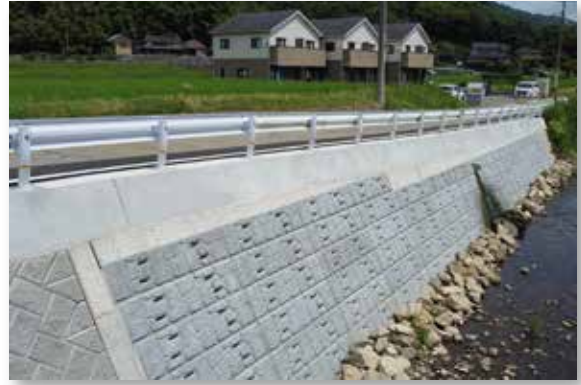
■道路災害復旧工事(市道八幡町77号線) ■ 広島県 三原市役所(ひととせ)
