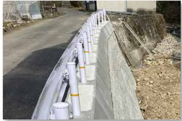
■二級河川沼田川水系徳良川河川災害復旧工事 ■ 広島県 東部建設事務所 三原支所
