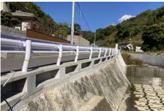
■町道天地川1号線外災害復旧工事 ■ 広島県 坂町役場 (T型)
