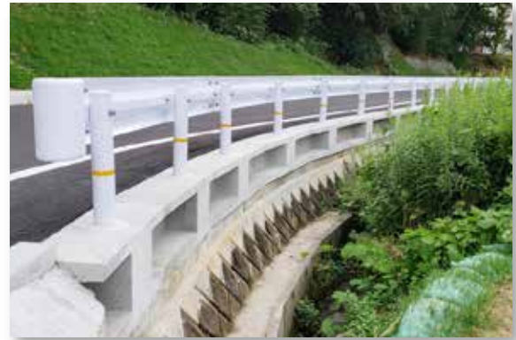
■七条柵坂西3号線道路改良工事 ■ 広島県 東広島市役所 (T型)
