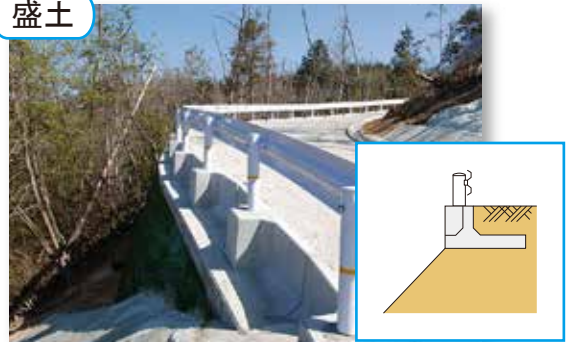
曲線施工・縦断勾配施工
